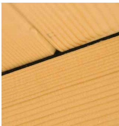
Sigillatura all'aria dell'appoggio delle perline sulla trave di timpano.
