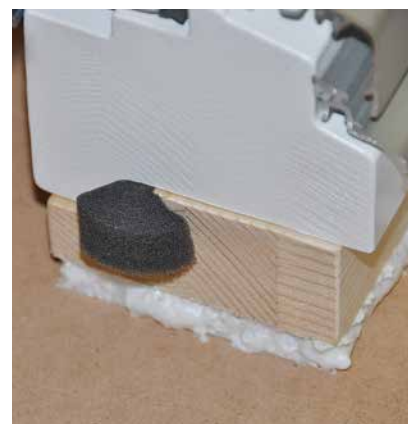
Sigillatura all'aria tra serramento e falsotelaio.
