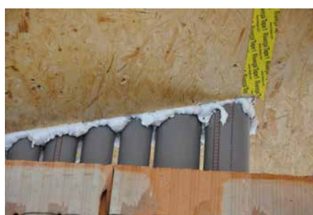
Riempimento di cavità, fughe ed interstizi tra le strutture edili
