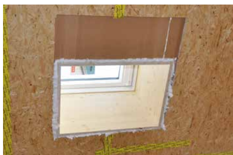
Riempimento delle fughe sul perimetro delle finestre da tetto
