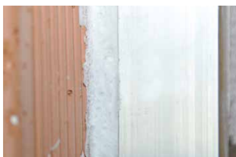
Riempimento tra muratura e falsotelaio
