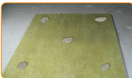
Stendere la colla a tasti sul pannello a terra
