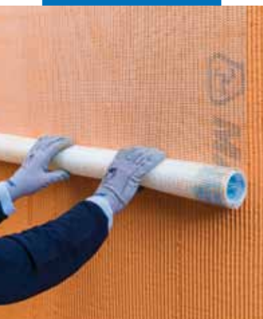
Posizionamento di Mapetherm Net
