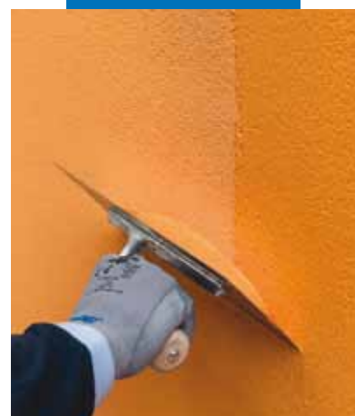
Finitura con applicazione a spatola di Elastocolor Tonachino Plus su Mapetherm Flex RP 1,5 mm
