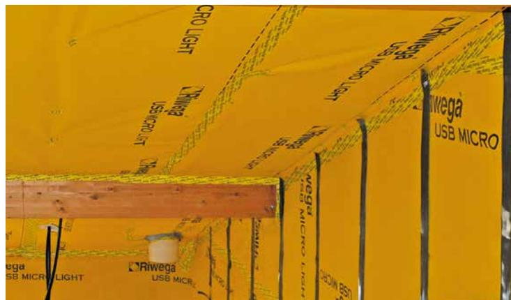
USB MICRO LIGHT quando viene posato come freno al vapore all'interno delle strutture viene poi rivestito da pannelli in cartongesso o fibrogesso, e per questo motivo viene forato dalle viti di fissaggio dei pannelli o delle strutture di supporto. Per evitare il passaggio di vapore attraverso questi fori, e per garantire una perfetta tenuta all'aria, è necessario utilizzare la guarnizione USB TIP KONT nei punti di fissaggio dei pannelli.
