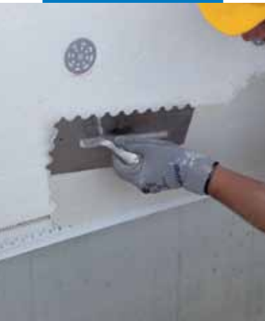
Posa di Mapetherm Rompigoccia con Mapetherm AR1 Light
