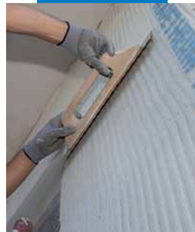
Inserimento della rete d'armatura Mapetherm Net
