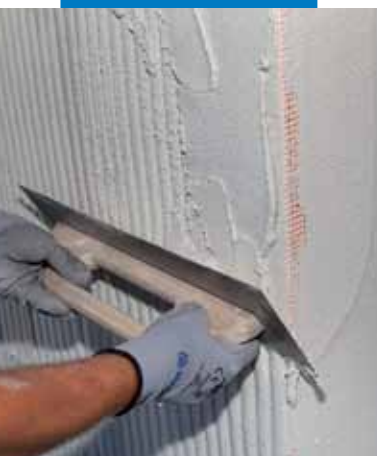
Stesura della prima mano di rasante Mapetherm AR1 Light
