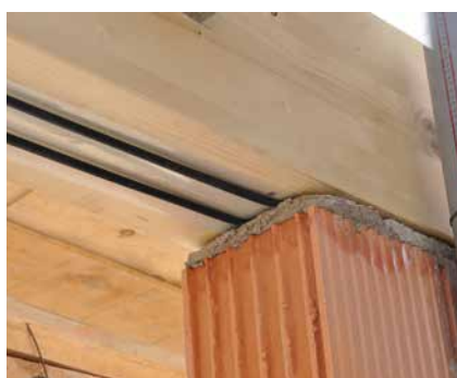
Sigillatura dell'appoggio della trave di banchina
