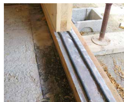
Sigillatura dell'appoggio di una parete in legno
