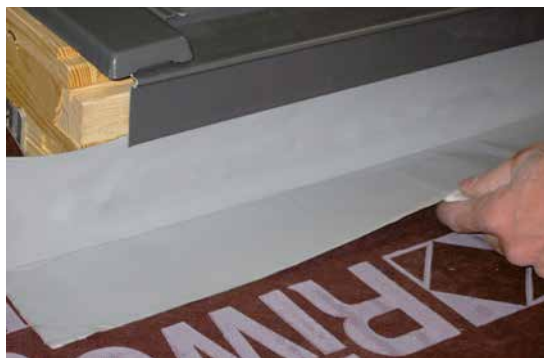
2. Posa del nastro USB Coll 150 X sul lato basso della finestra
