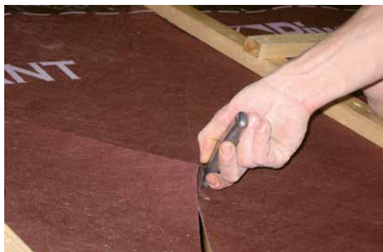
1. Taglio dello schermo traspirante USB Riwega
