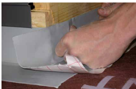
5. Posa del nastro USB Coll 150 X sul lato alto della finestra
