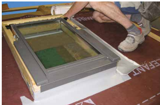
4. Applicare USB Coll 150 X sui due lati esterni della finestra
