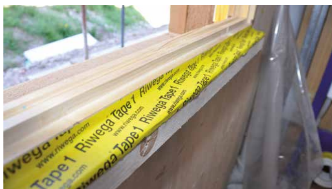
USB Tape 1 PAP X3 a sigillatura tra falsotelaio e parete in legno
