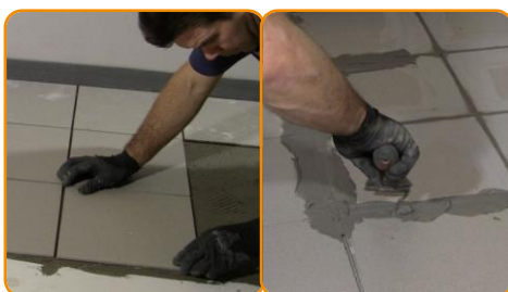
Posare la pavimentazione in ceramica o legno
