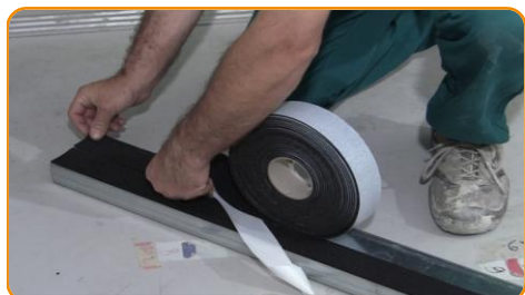
Incollare alle guide metalliche la striscia adesivizzata Stywall S3A
