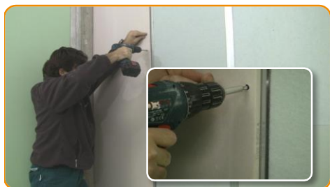
Fissare le lastre in cartongesso sui profili metallici per chiudere la parete
