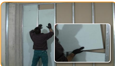
Inserire tra un profilo e l'altro i pannelli di Trywall
