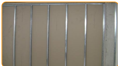
Fissare le lastre di cartongesso da un lato
