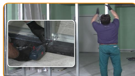
Inserire i profili metallici e fissarli alle guide
