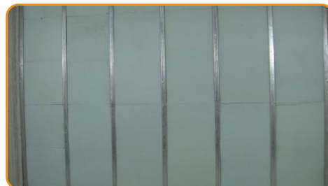
Completare l'inserimento del prodotto tra i profili
