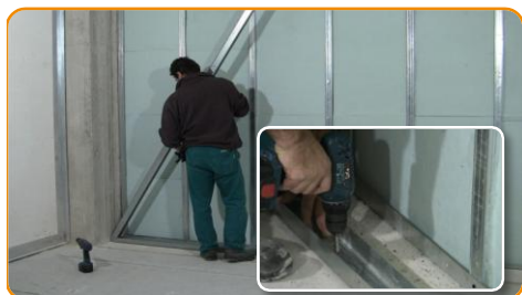
OPZIONE - DOPPIA STRUTTURA Realizzare la seconda struttura metallica per creare una parete doppia
