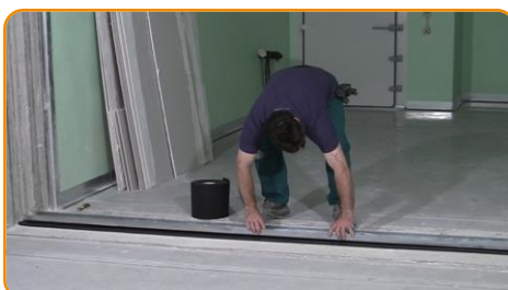
Fissare le guide metalliche al solaio, alle pareti laterali e al soffitto
