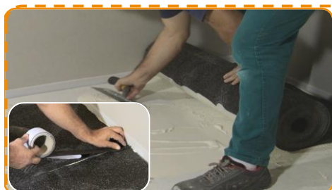
POSA A COLLA: Posare uno strato di colla, stendere il Sylwood, nastrare con il nastro Stik le giunzioni e incollare il parquet
