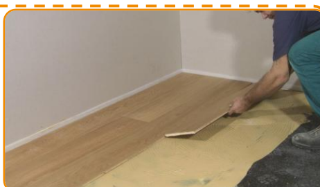
POSA A COLLA: Posare uno strato di colla, stendere il Sylwood, nastrare con il nastro Stik le giunzioni e incollare il parquet
