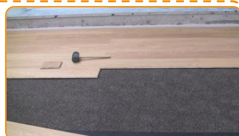
POSA A SECCO: Posare il Sylwood, nastrare con lo Stik le giunzioni dei rotoli, posare a secco le tavole di parquet
