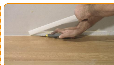
Rifilare la striscia perimetrale Profyle Flat 5
