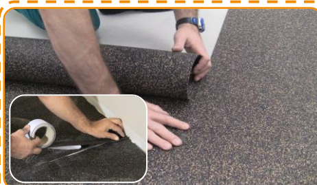
POSA A SECCO: Posare il Sylwood, nastrare con lo Stik le giunzioni dei rotoli, posare a secco le tavole di parquet
