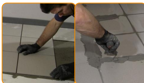
Posare la pavimentazione in ceramica o legno
