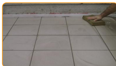
Ad inizio indurimento della fuga, pulire la superficie delle piastrelle
