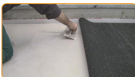
Posare un sottile strato di colla, stendere il Sylcer
