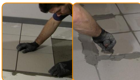
Posare la pavimentazione in ceramica o legno
