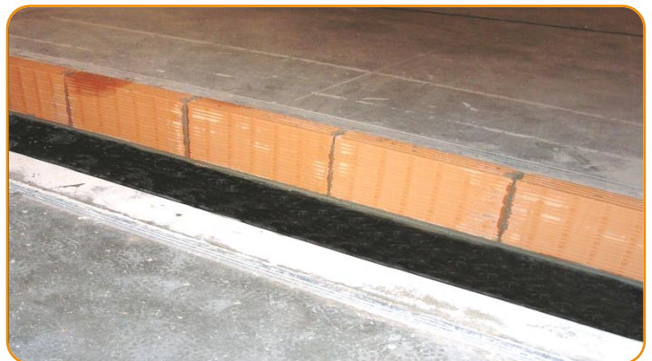
Realizzare la prima parete sopra la striscia sottoparete posandola su un letto di malta
