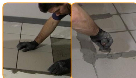
Posare la pavimentazione in ceramica o legno
