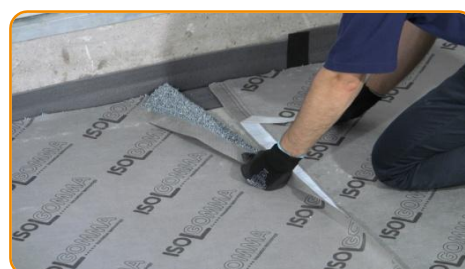
Incollare la cimosa adesiva aiutandosi con le linee di sormonto
