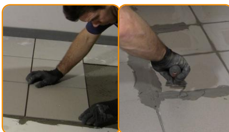
Posare la pavimentazione in ceramica o legno
