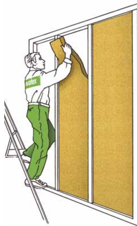
Montaggio dai pannelli PAVAFLEX.
